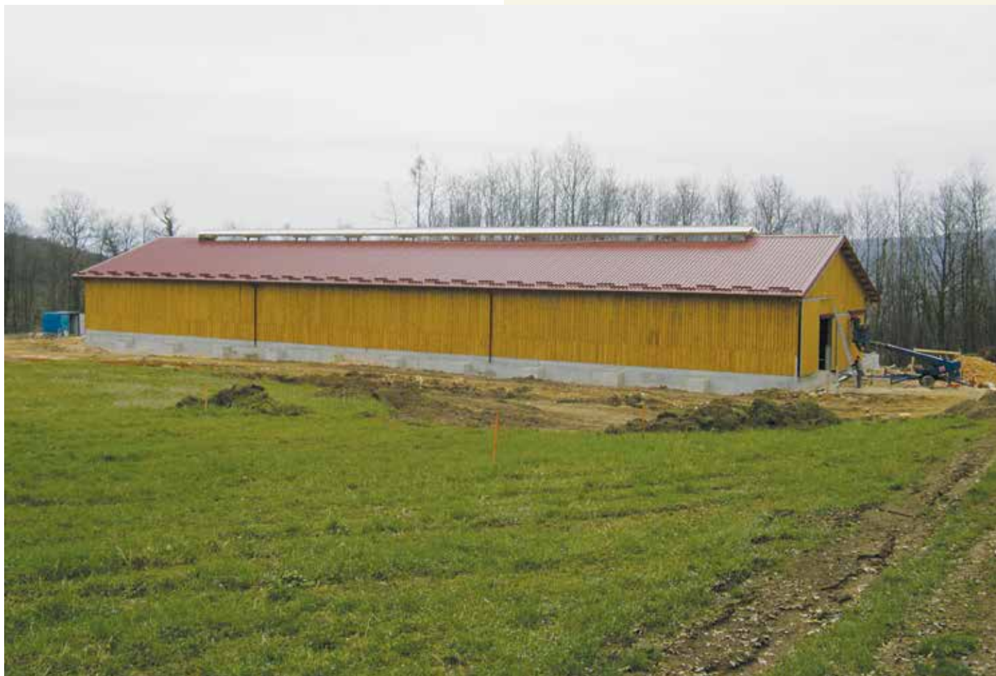
Izgradnja infrastrukturnega centra za istrsko govedo v Pazinu, marec 2013
